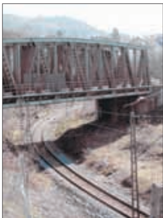
Im Abschnitt Haltingen-Weil am Rhein haben der vorbereitenden Bauarbeiten für den Ausbau der Rheintalbahn begonnen.
